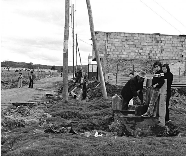
Saúl Ordúz, Trabajo Acueducto Barrio Nueva Caledonia , 1980
