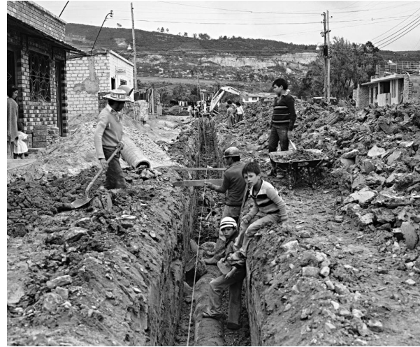
Saúl Ordúz, Trabajos Acueducto Barrio Verbenal , 1980
