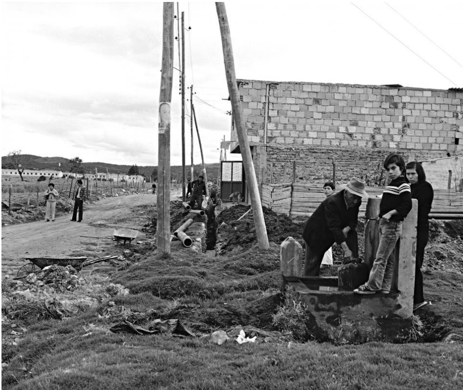
Saúl Ordúz, Trabajo Acueducto Barrio Nueva Caledonia , 1980
